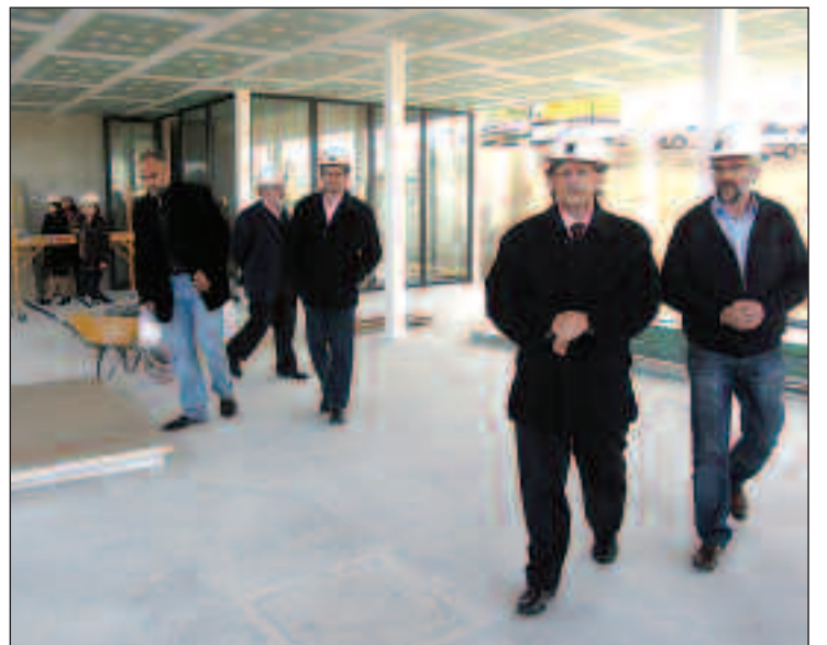
El conseller de Salut i Consum durante su visita a las obras de la nueva UBS de Maria.
